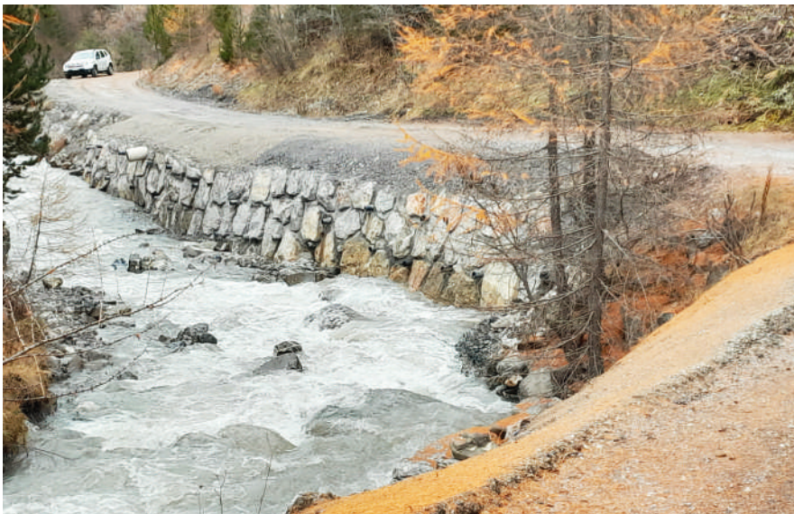
» Travaux confortement berges du Chagnes - route des Sagnes à Vars Ste Marie
