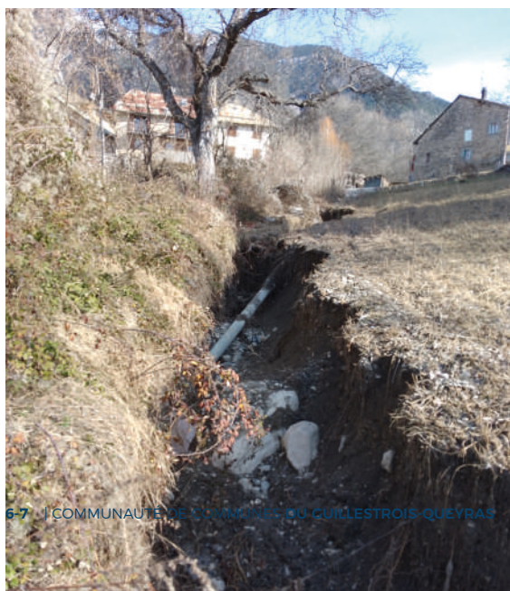
» Tuyau réparé au hameau de la Rua d'Alay
