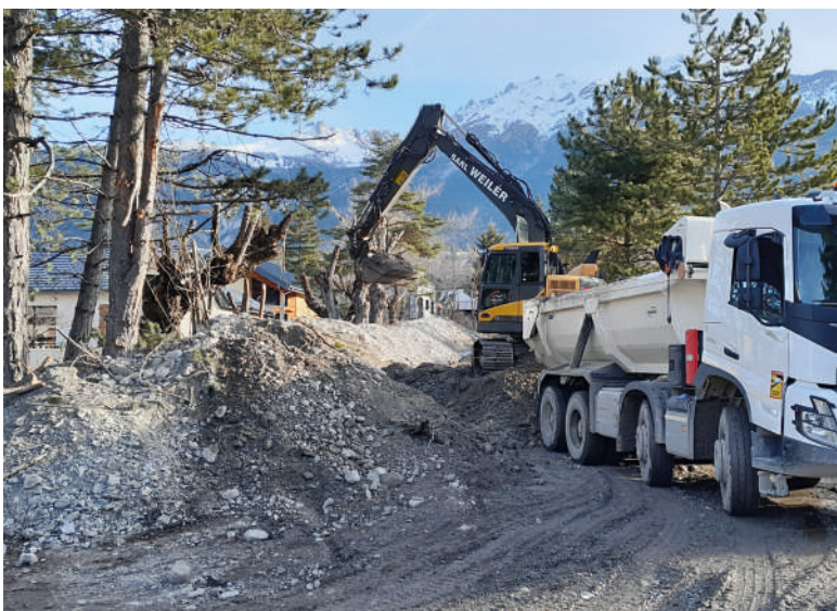
>> Travaux post-crués torrent Ste Catherine à Eyglies
