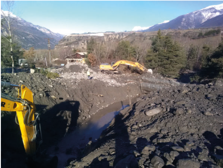
>> Travaux urgence sur le Chalps à Guillestre
