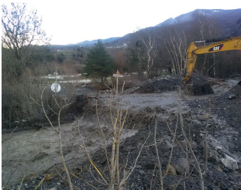
>> Travaux d'urgence sur le Palps aux Isclases à Risoul
