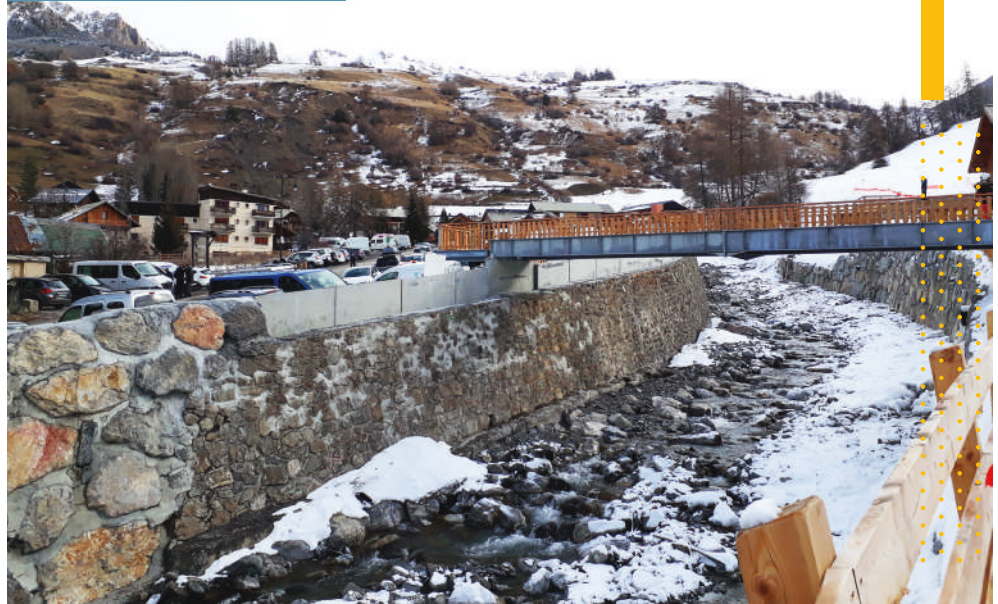
» Travaux de reconstruction de la passerelle piétonne du Chagnon - Vars
