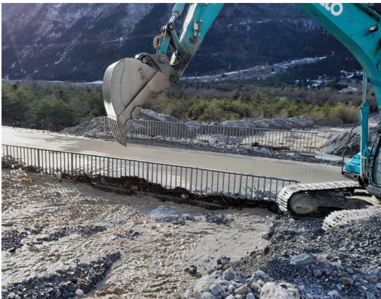
>> Travaux urgence sur Merdanel à St-Crépin
