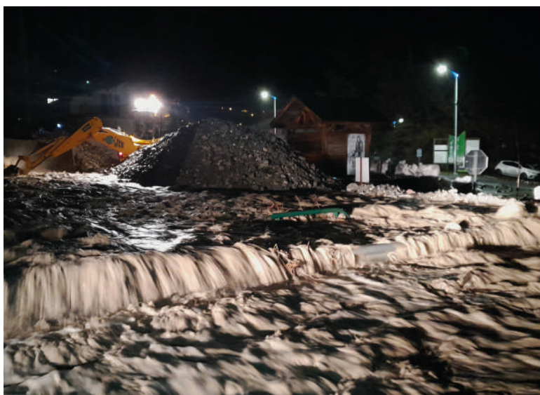
>> Travaux urgence crue du Guillermin à St Crépin
