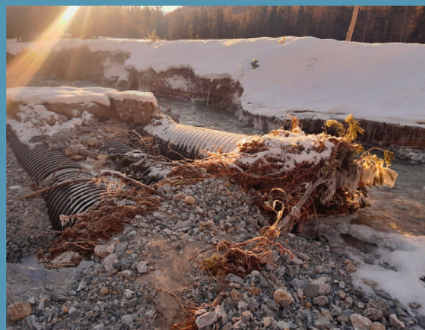
» Traversée de torrent du site d'Arvieux
