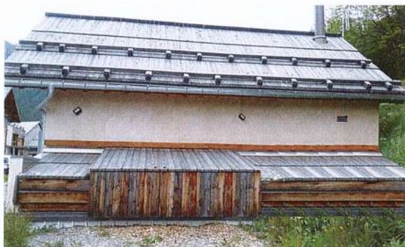
Trappe du silo après travaux
