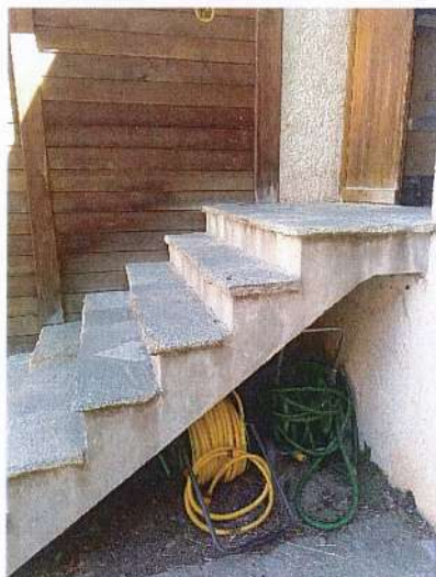
Accès extérieur à la chaufferie avant travaux
