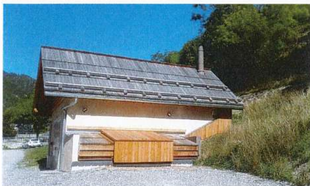
Trappe du silo avant travaux
