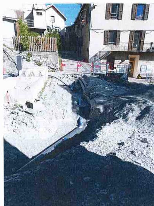
*Réfection réseaux eau potable, eaux usées, création de réseau pluvial et réfection de voirie -Travaux coordonnés avec la commune de St Crépin*
