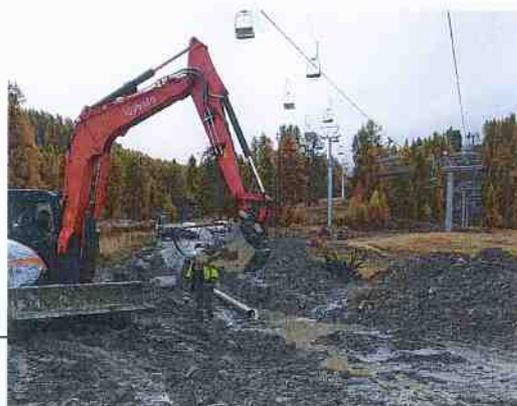
*Travaux de renouvellement du réseau d'eaux usées entre le télésiège de Peyrefolle et la station de Risoul.*
